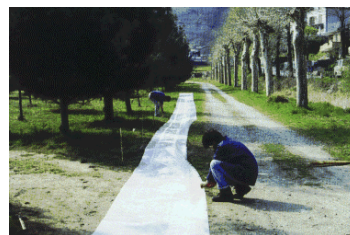
la posa delle barriere anti-attraffamento di Anfibi nell'abitato di Sorico (Como)
